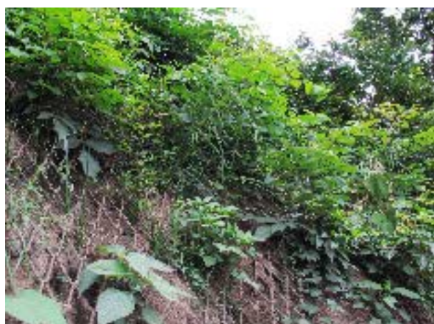
自然の植生を生かした施工例
