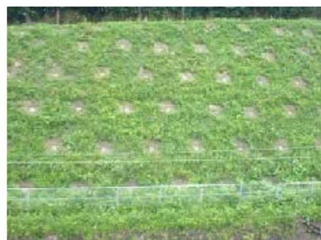
平滑な法面の施工例
