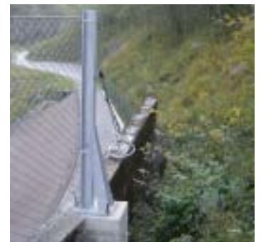
擁壁上に設置
