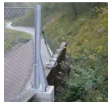
擁壁上に設置
