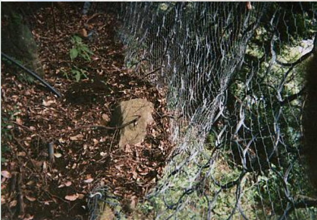
落石・堆積土砂の状況 (落石: V=0.5 \times 0.4 \times 0.4 = 0.08 \text{ m}^3 )
