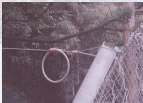
端末スパンのリテイニングロープブレーキリング 作動状況(作動量10cm程度)
