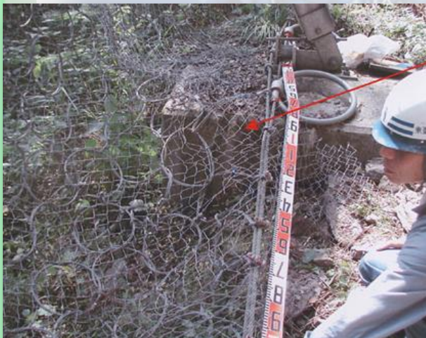
変形の大きな5個のリングのみ交換 (リング交換前)
