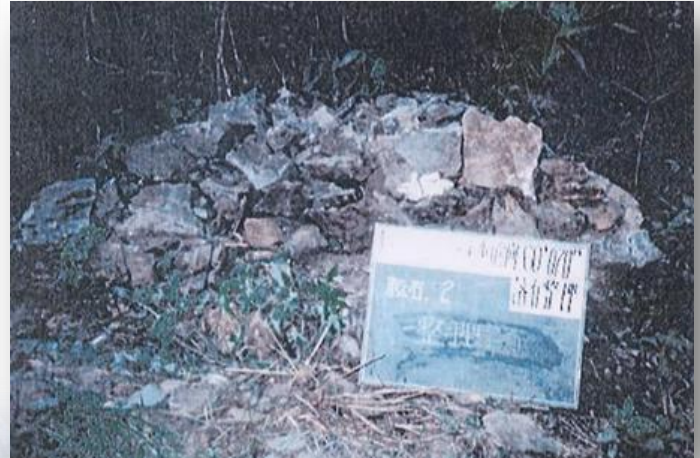
小割りした石は、防護柵の背面斜面に片付け
