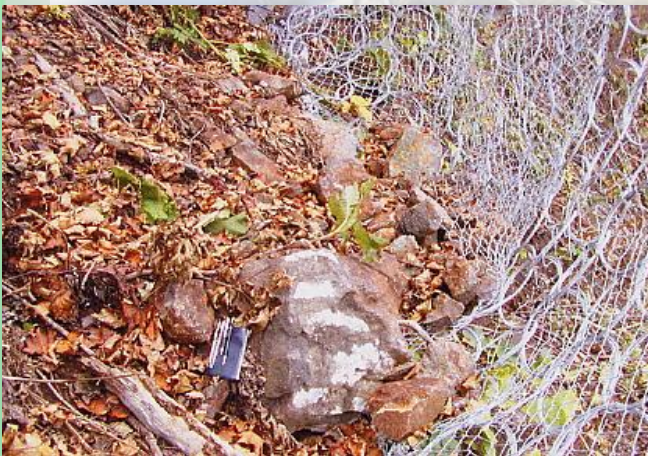
落石・堆積土砂の状況 落石:V=0.7*0.5*0.3=
