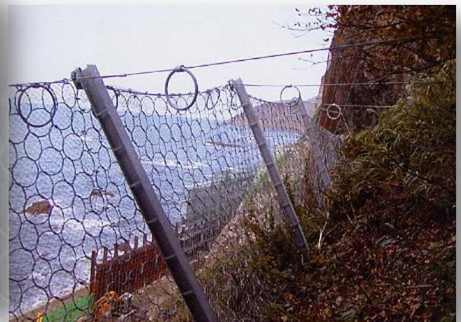
RN柵の状況 (支柱、サポート・リテイニングロープ。ブレーキリング関係)
