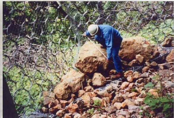
落石寸法 1.2×1.2×0.8 落石質量 約3t
