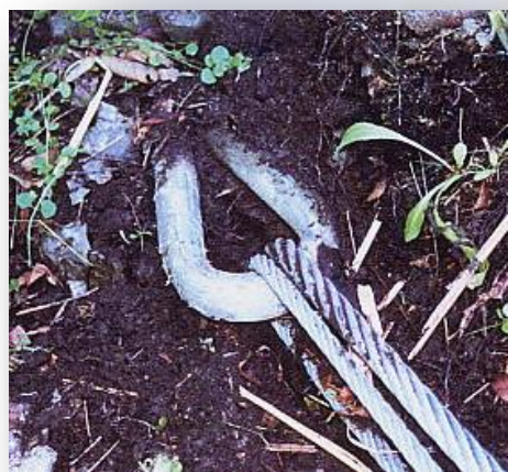
アップスロープアンカー状況
