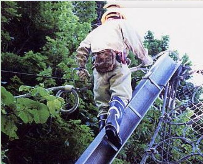
No. 4支柱 頭部状況
