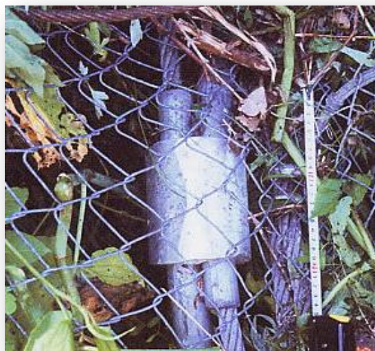
下部サポートロープブレイキング状況
