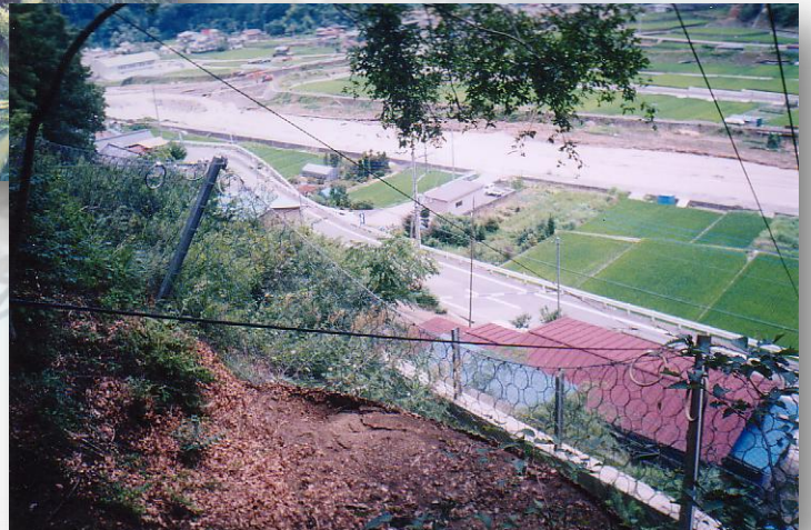
土砂堆積厚:約1.5m
