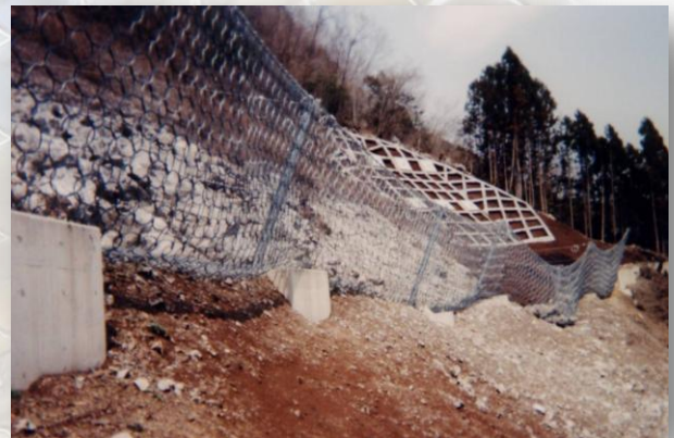
支柱基礎はコンクリートブロック
