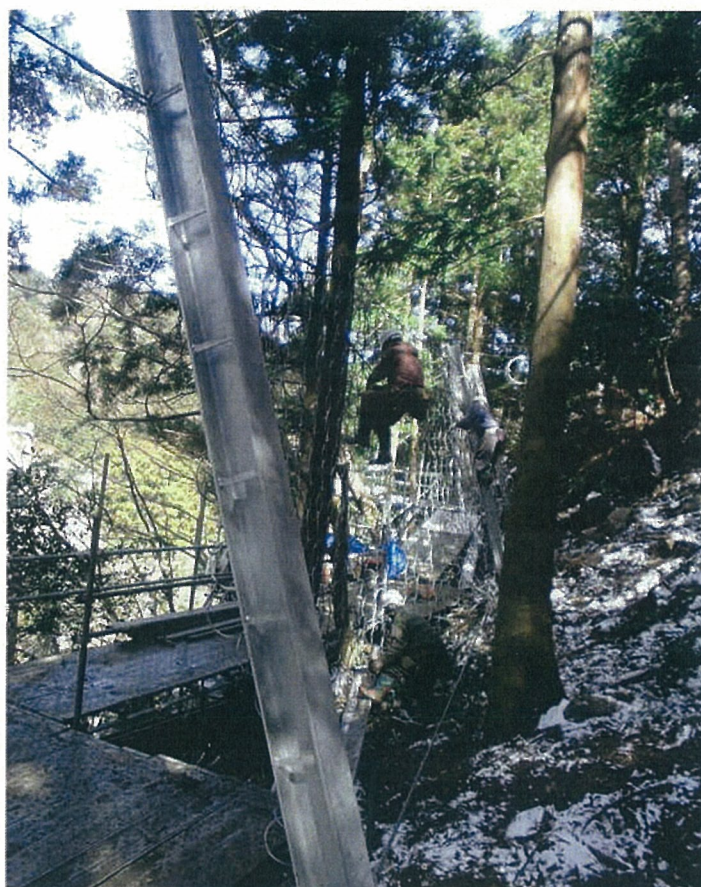
写真3.樹林帯でのリングネット施工(三重)
