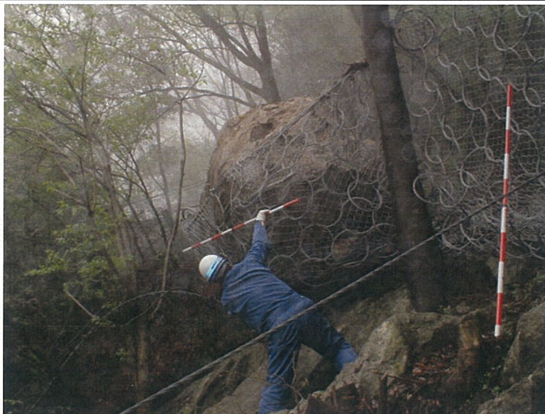
写真5.落石を捕捉したリングネット柵(三重県)
