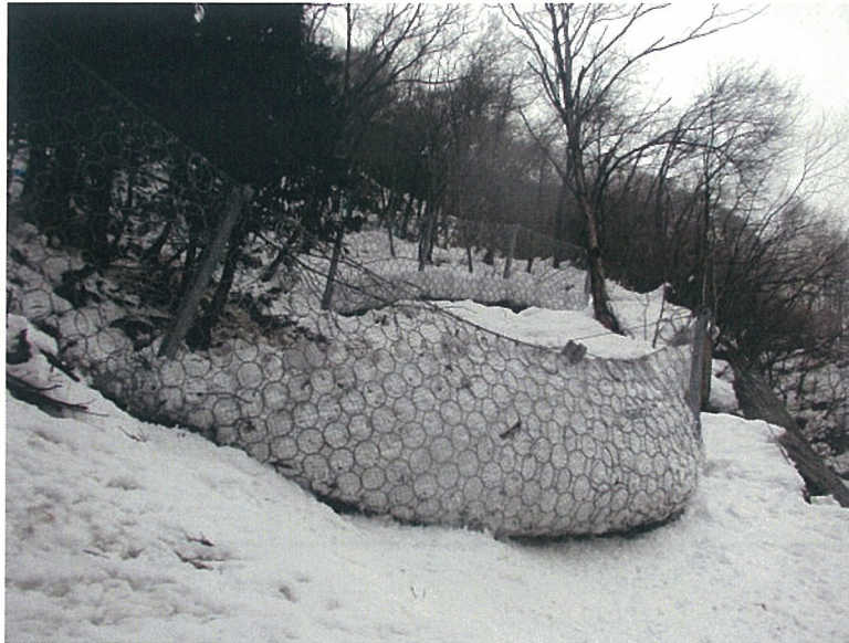
写真7.雪崩を捕捉したリングネット柵(福島県)
